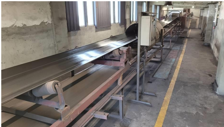
Fot. 2: Wewnętrzna część estakady
