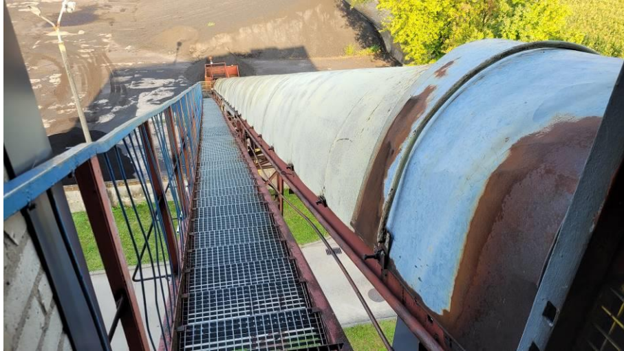
Fot. 1: Widok zewnętrznego biegu schodowego od strony budynku kotłowni
