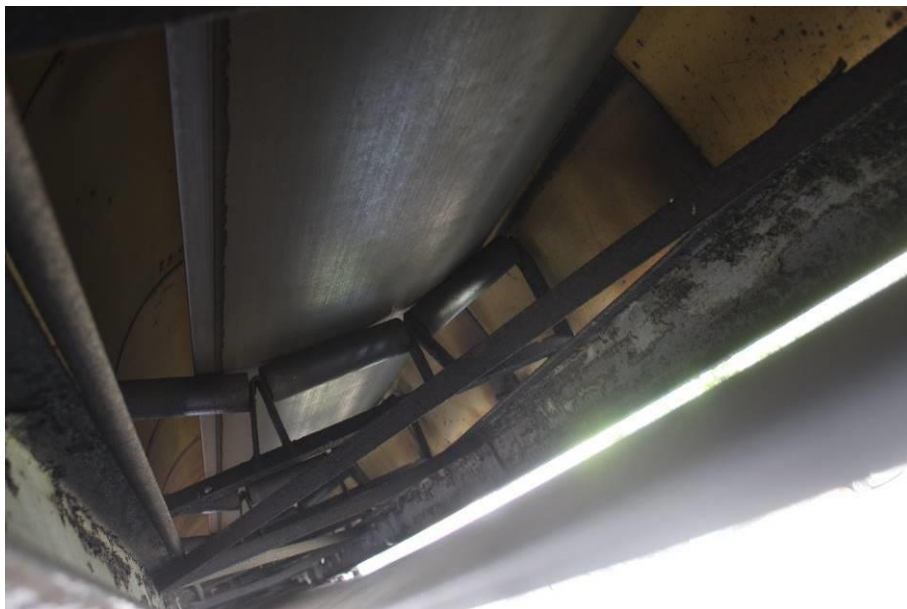
Fot. 4: Elementy prowadzenia taśmy estakady wraz z elementami stężącymi ceowniki nośne
