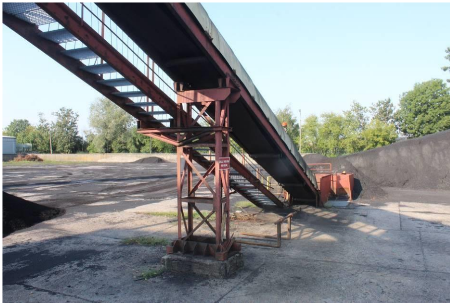
Fot. 3: Słup estakady zewnętrznej
