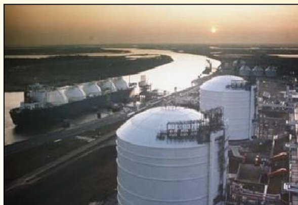
Regazyfikacja i magazynowanie - terminal LNG w Świnoujściu
