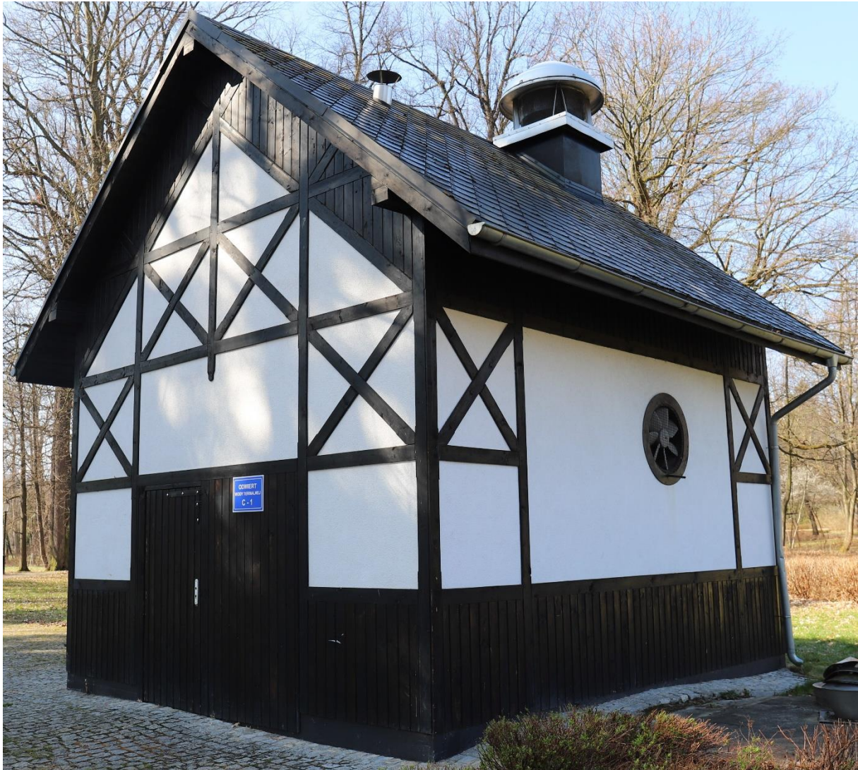
Na zdjęciu: Zabudowa odwiertu wody termalnej w Parku Zdrojowym w Cieplicach
